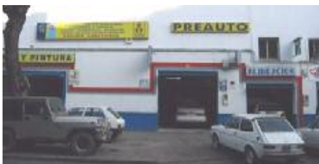
Imagen de nuestras instalaciones de la Avda. San Juan de la Salle
